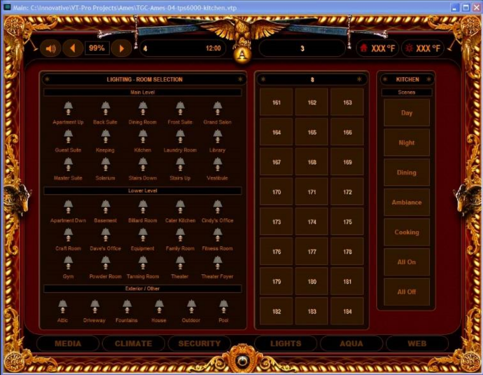
Actual Installed Light Controls
